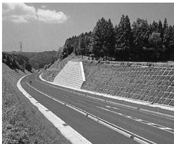
国道118号線バイパス改築工事 (棚倉町)
