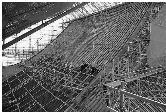
浅草寺、本堂の屋根葺き替え作業
