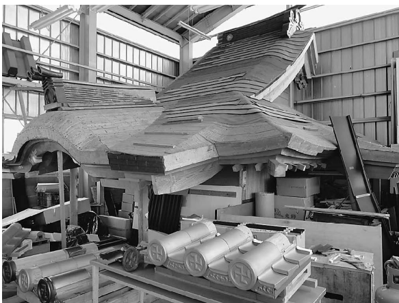
技術研修センター内 屋根模型、手前にあるのがチタン瓦
