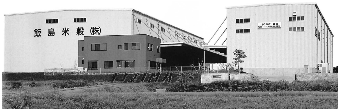
本社社屋・工場・倉庫
