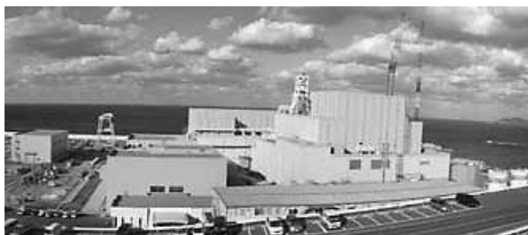
建設が進む島根原子力発電所3号機（中国電力）
