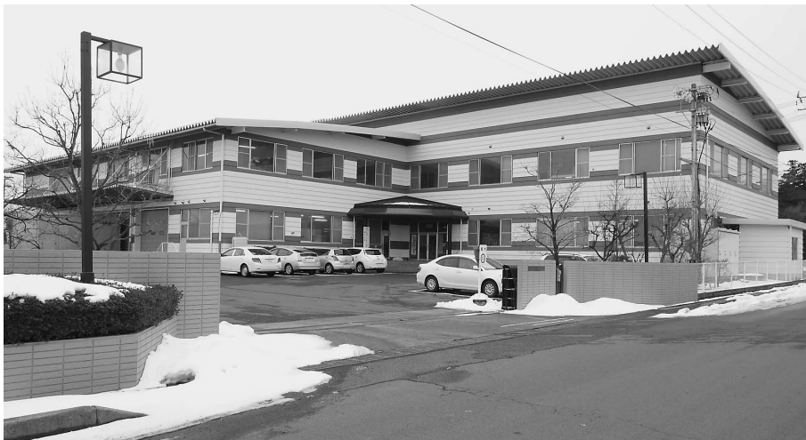
本社工場・本社社屋
