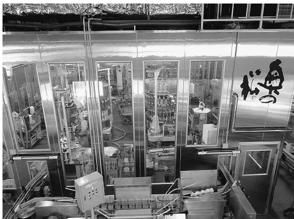
パストライザーシステムにより瓶詰を行う設備
