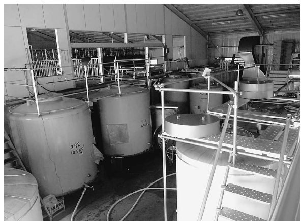
日本酒類を工場内で貯蔵するタンク
