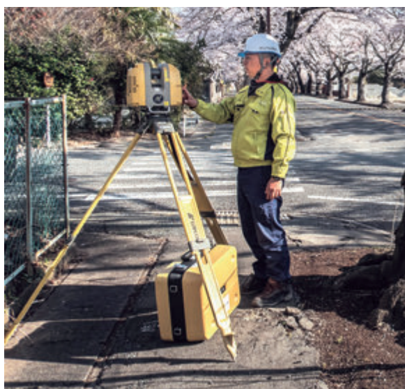
3Dレーザーキャナでの測量
