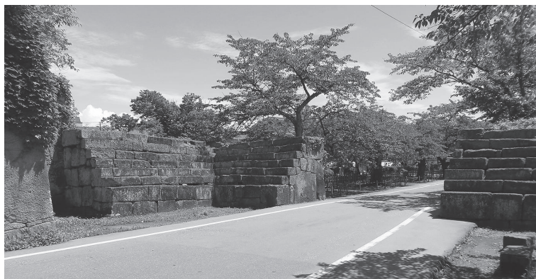
改修され新たにもうけられた防御の拠点・北出丸の石垣
