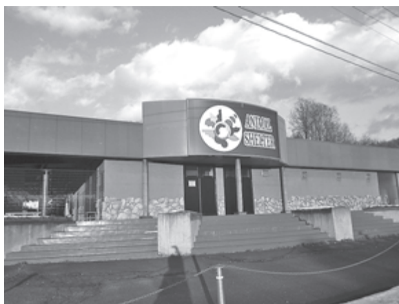
改修前の「三春シェルター」
